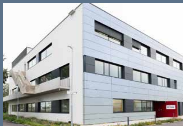
Am Biomay-Standort in Wien plante und errichtete die VTU eine hochmoderne Biotech-Anlage.
